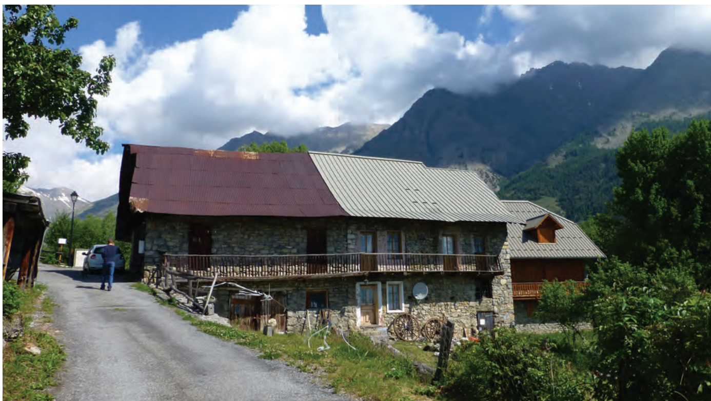
CAUE 05 / HKlinger / Réallon Le Roux / Les constructions traditionnelles tirent parti de la pente
