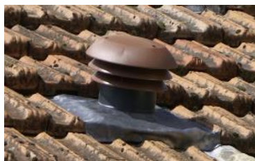
Exemple débouché d'extraction de VMC en maison individuelle (MI)
