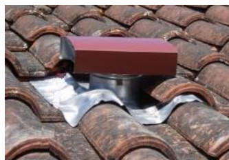
Exemple débouché d'extraction de VMC en maison individuelle (MI)
