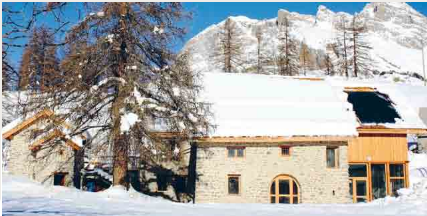
Le Fontenil, Le Monêtier-les-Bains : Le l'enneigement important en altitude n'est pas un obstacle au fonctionnement des capteurs solaires
