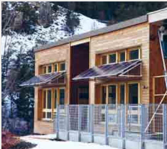
Saint-Martin-de-Queyrières : capteurs solaires en "casquette" pare-soleil sur une école
