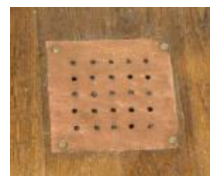
Grille dans le plancher
