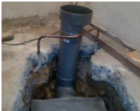
Installation du puisard
