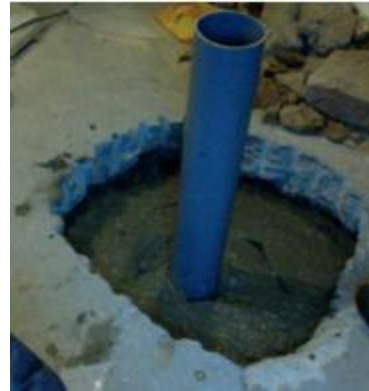
Installation du puisard
