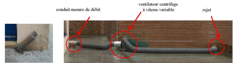
Extraction mécanique de la gaine technique
