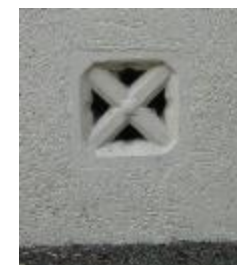
Entrée d'air dans le VS
