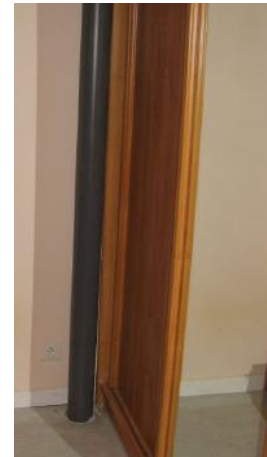
Conduit d'extraction
