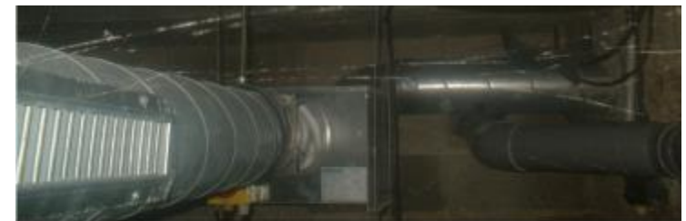
Groupe d'extraction dans la gaine technique
