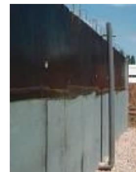
Point d'extraction extérieure avant remblai
