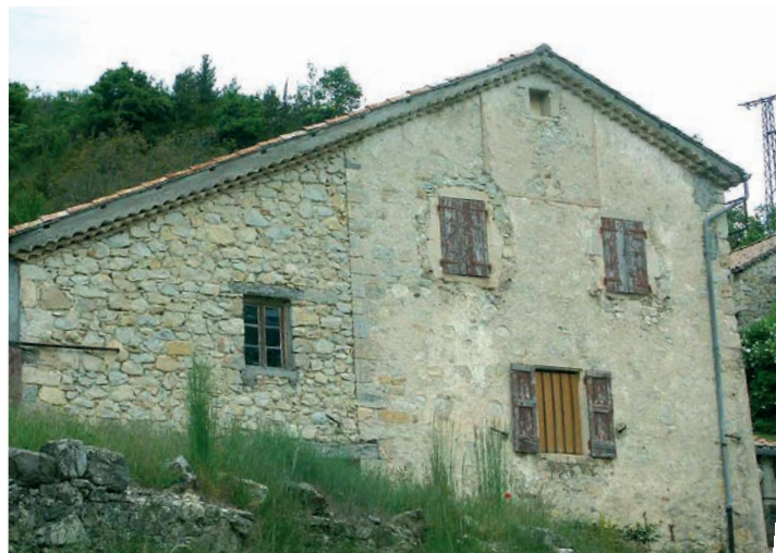
Extension par prolongement de toiture de la construction initiale (Baronnies)
