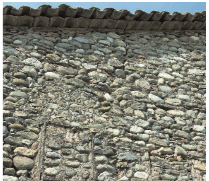
Appareillage de galets de rivière à Upaix
