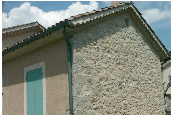
Traitements différenciés des enduits de façades (principales) et des ouvertures - (Baronnies)
