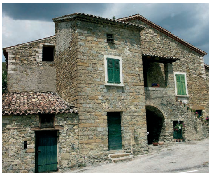
Combinaison de volumes au gré des extensions successives... dans un bel appareillage de pierres du rosannais (Ribeyret)
