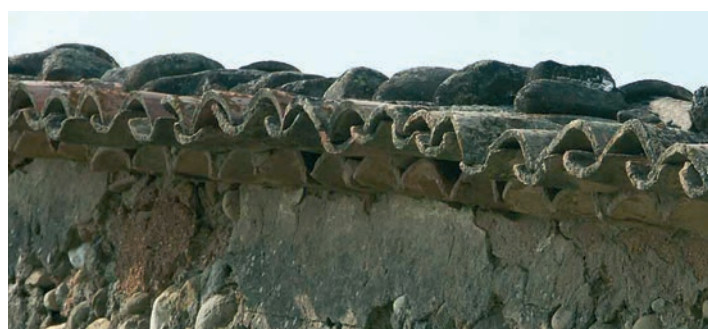
Génoise à un rang en façade pignon (Upaix)
