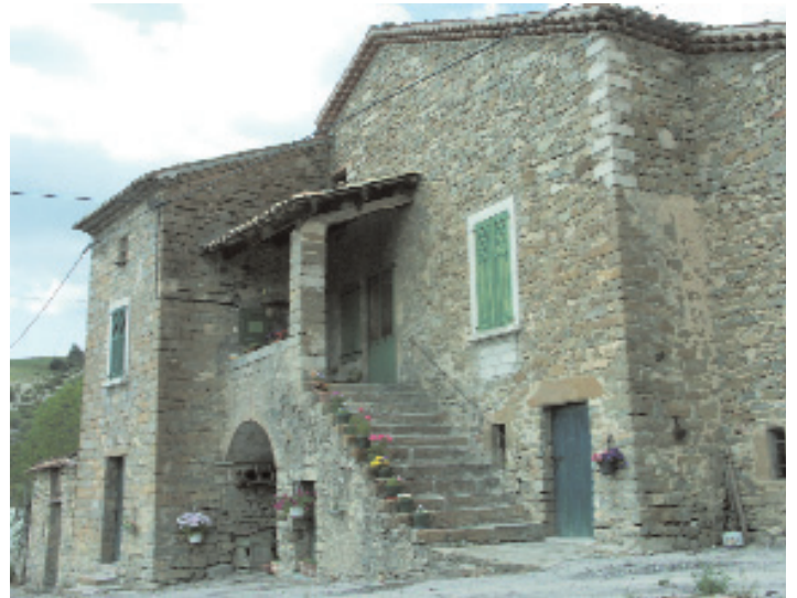
Eléments particuliers d'architecture en façade principale(Ribeyret)
