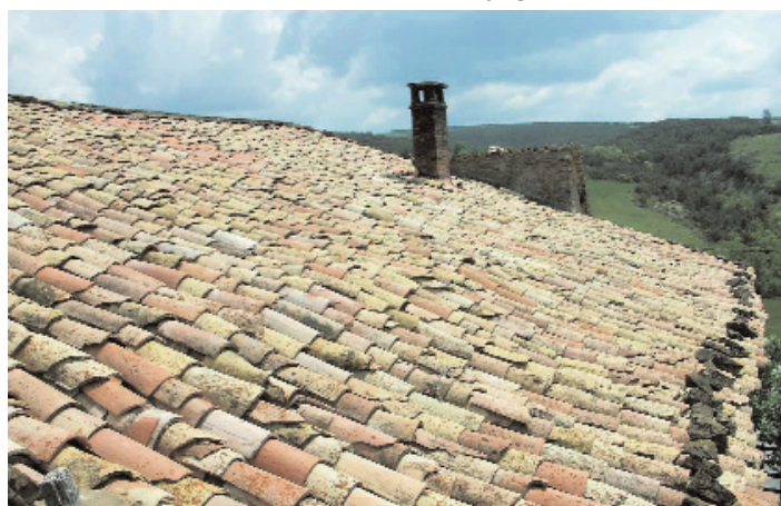
Une couverture omniprésente dans le paysage : la Tuile canal
