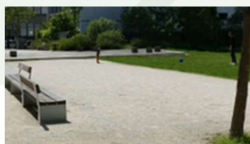
Sol en sable stabilisé, Jardin Luc Hoffmann, Paris © caue05
