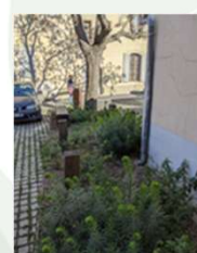
Récupération des eaux pluviales vers l'espace végétalisée © ARBE
