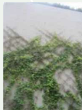
Mur végétalisé sur câbles tendus ©CAUE de Paris
