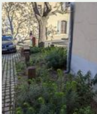
Récupération des eaux pluviales vers l'espace végétalisée © ARBE
