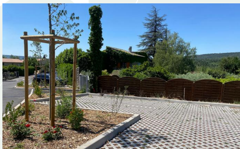
Désimperméabilisation d'un parking – Eco-Quartier de Volonne (04 –France) ©ARBE
