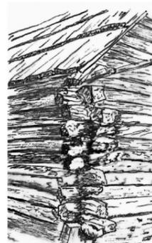
Détail d'une fuste en mélèze, partie surmontant les rez de chaussée pour le stockage des fourrages et céréales, dans l'habitat traditionnel de la Clarée, du Queyras et du Briançonnais
