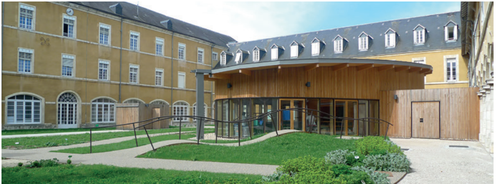
Plateau de rééducation, Montfaucon, Philippe Bergès-phBa architectes © architectes
