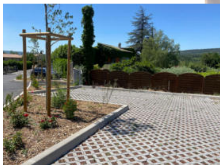
Désimperméabilisation d'un parking ©ARBE
